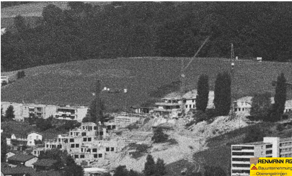
Am Ende der Eggstrasse Nr. 53 - 57, kamen um 1974 nochmals der EWK SBK 25 «Rex» der Firma W. Seiler und der +Swiss-Crane+ TKF 601 zum Einsatz. Für die Terrassenhäuser zwischen der Rebbergstrasse und der Eggstrasse, gelegen auf dem ehemaligen Bauernhofaral der Fam. Simmen, setzte die die Firma Surenmann aus Oberengstringen einen Kroll K 62 ein, links im Bild. Foto ETH Bildarchiv.
