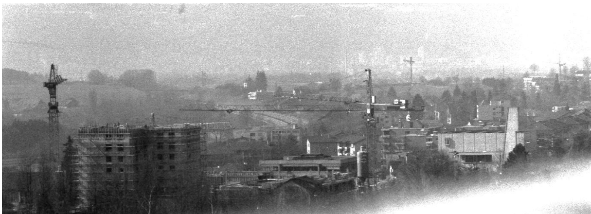
Zentrumsbaustelle. Foto Pius Meyer.
