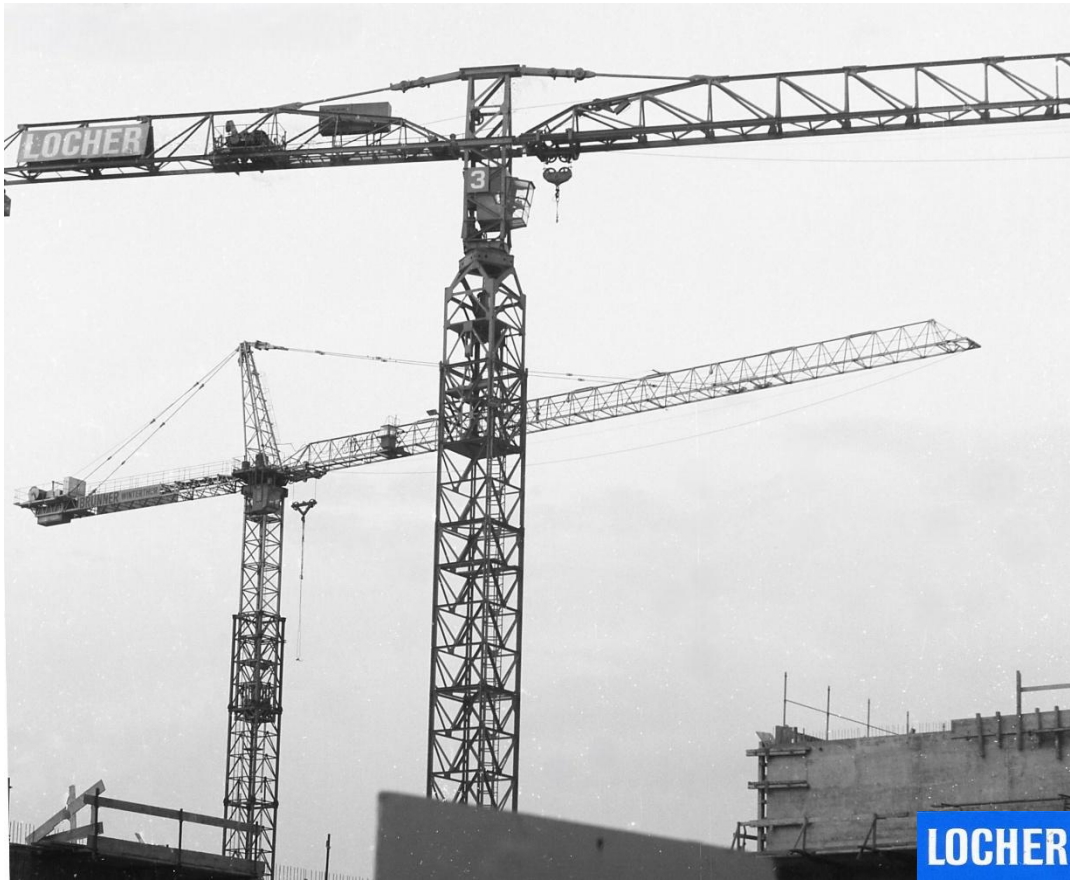
Baustelle des Zentrums Regensdorf April 1972. Richier- Weitz GT 1295 R5 und Peiner KL 160. Foto Pius Meyer.
