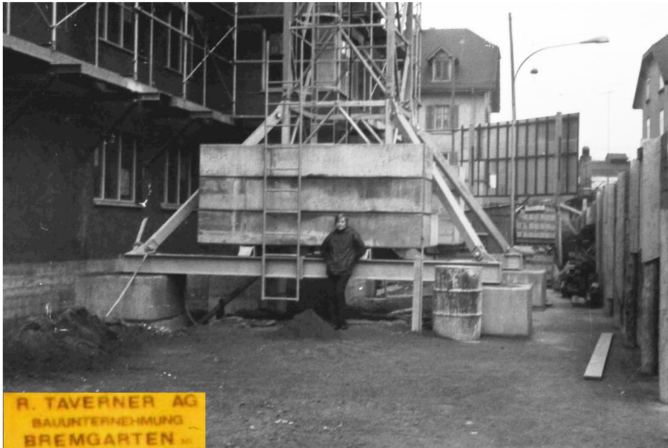
1971 begannen die Bauarbeiten für einen Wohnblock an der Sonnenhofstrasse in Schlieren, mit einem damals neuen +Swiss-Crane+ TKF 601, der Baufirma Taverner aus Bremgarten. Im Bild der Unterwagen mit meinem damaligen Schulfreund. Foto Pius Meyer.
