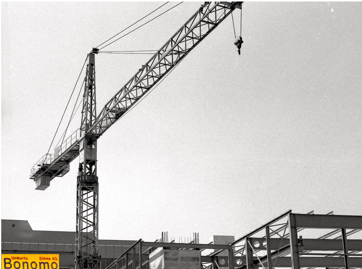
1976/ 77 kommt der +Swiss-Crane+ TKF 1200 der Firma Umberto Bonomo's Söhne aus Zürich für die Erweiterung des Wasserwerks Zürich zum Einsatz. Mit Baujahr 1967 war der Kran damals bereits 10 Jahre alt. Foto oben und unten Pius Meyer.
