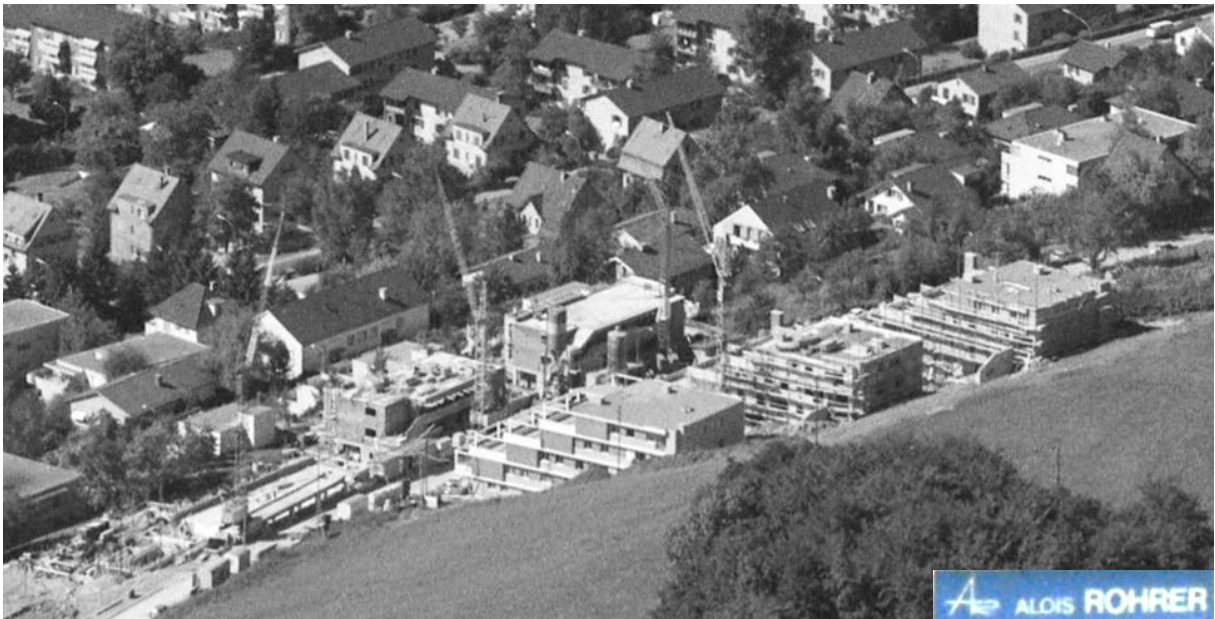
Die Firma A. Rohrer Ing. aus Zürich setzte ebenfalls an der Eggstrasse, um 1970, einen IBAG F 30, einen Kroll K 25 und einen PKZ-Form 18 ein. Foto ETH Bildarchiv.
