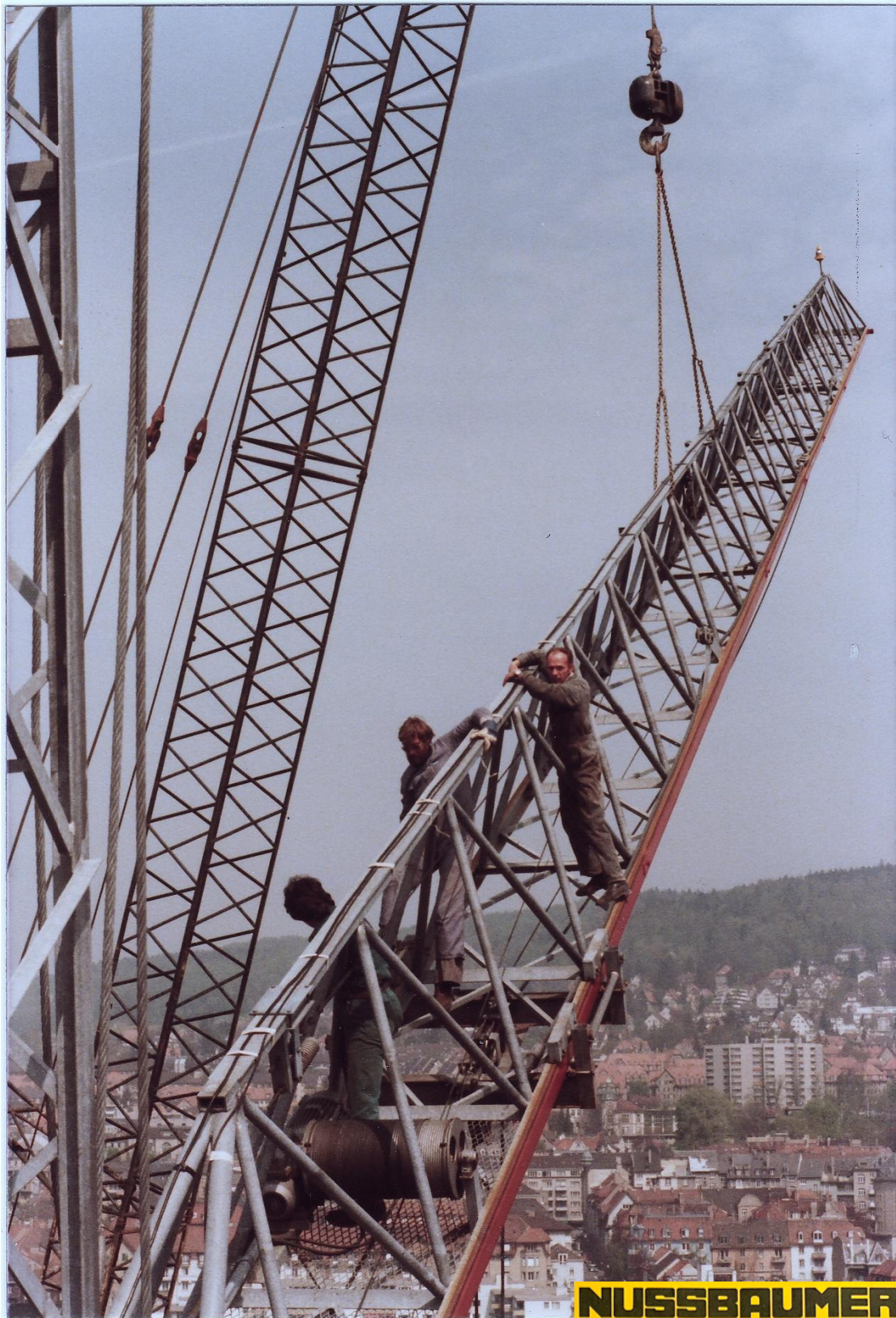
Nach dem Abklettern wurde der Kran mit dem Gittermastautokran Demag TC 500 von Toggenburger demontiert. Foto Urs Frischknecht 1980.
