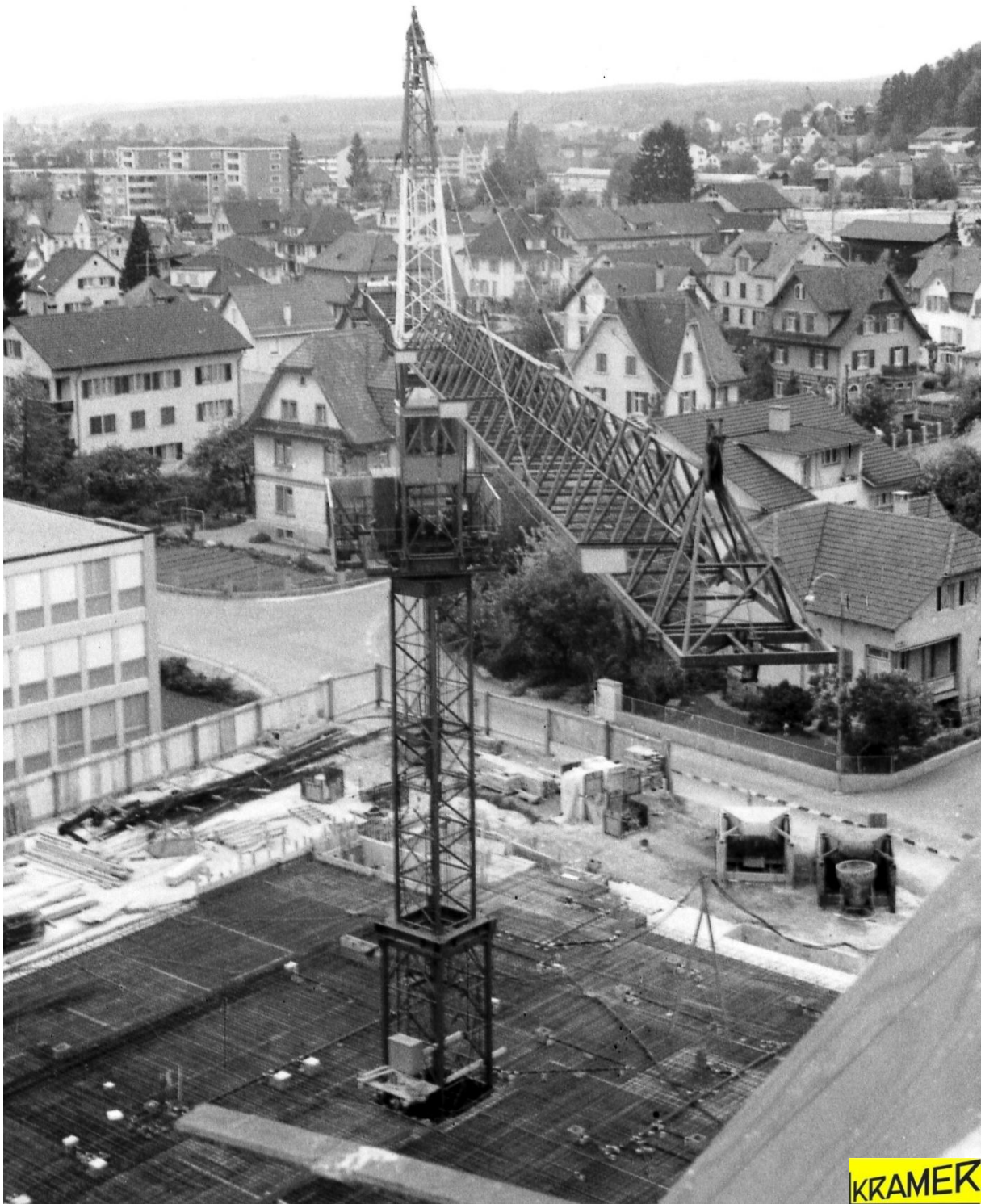
Peiner KL 80 in der ersten Ausführung von 1966. Foto Zentrum Illuster von 1972. Foto Pius Meyer.
