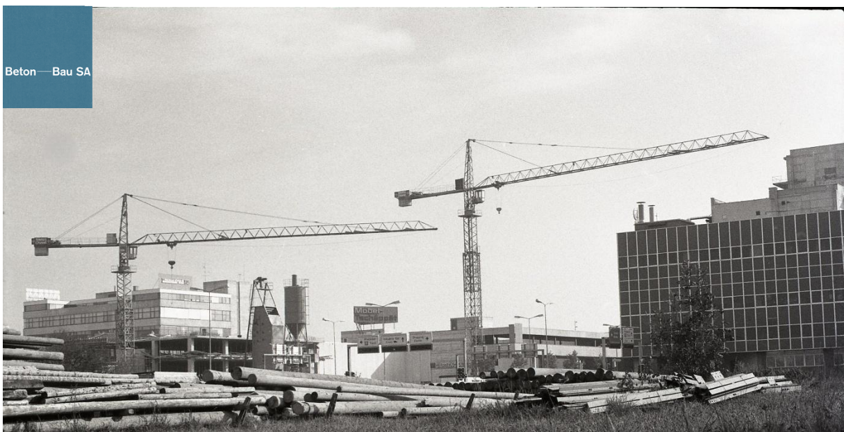
1979 kam es zu einem Comeback von H.H. Rinderknecht (Beton Bau AG), welcher zuvor schon das Shopping- Center und das Tivoli mit seiner Mannschaft erstellt hatte. Erstellt wurde eine Erweiterung von Möbel Gschwend. Eingesetzte Krane: +Swiss-Crane+ TKF 1200 und TKF 1000, beide mit Klettertürmen ausgerüstet. Anschliessend wurde die Erweiterung der Limmatdruck AG erstellt, mit den gleichen Kranen. Der TKF 1200 wurde auf 56 m Auslegerlänge verlängert. Fotos Pius Meyer.
