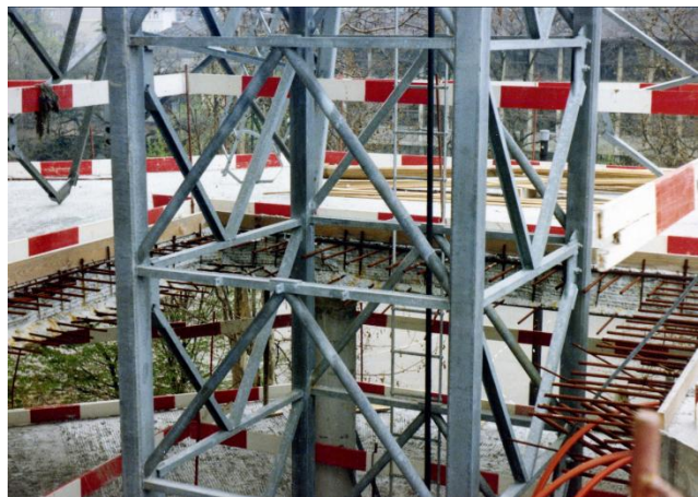
+Swiss-Crane+ TKF 1200 während des Abkletterns auf der Baustelle Migros Limmatplatz 1980. Um die Turmstückhälften entfernen zu können, musste am Gegenausleger eine Umlenkrolle angebracht werden. Foto Urs Frischknecht.
