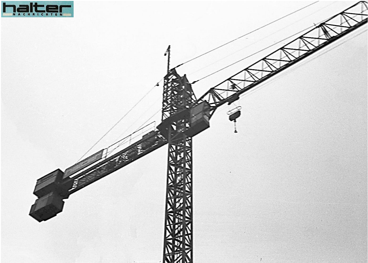
Kroll K 60 der Firma Halter Zürich auf der Grossbaustelle «Grünau» in Zürich. Die Hubwinde wurde aus Schutz vor Witterung und Lärm eingehaust. Foto Pius Meyer.
