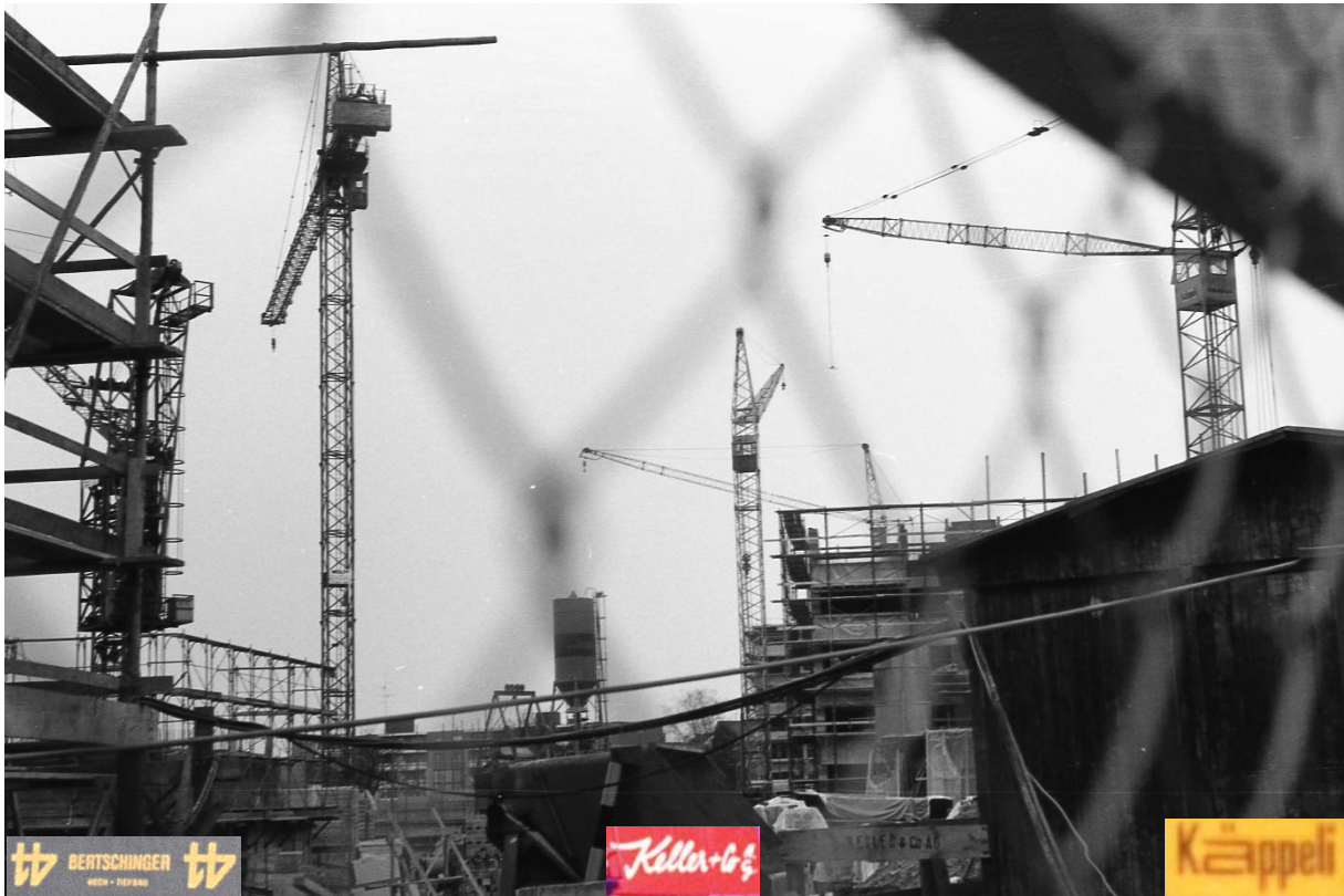
Zürich Seebach, Gebiet Köschenrütli, 1972. Neben einer neuen Schulanlage wachsen auch Neubauten aus dem Boden. Eingesetzte Krane: Schwing KTK 42 W der Firma Keller & Co., Wolff WK 80 S und EWK Gigant hoch der Th. Bertschinger AG, Wolff Form 45 H der Firma Keller & Co. und Liebherr 45A/65I der Firma Gebr. Käppeli & Co Zürich. Foto vom 05.03.1972 Pius Meyer.
