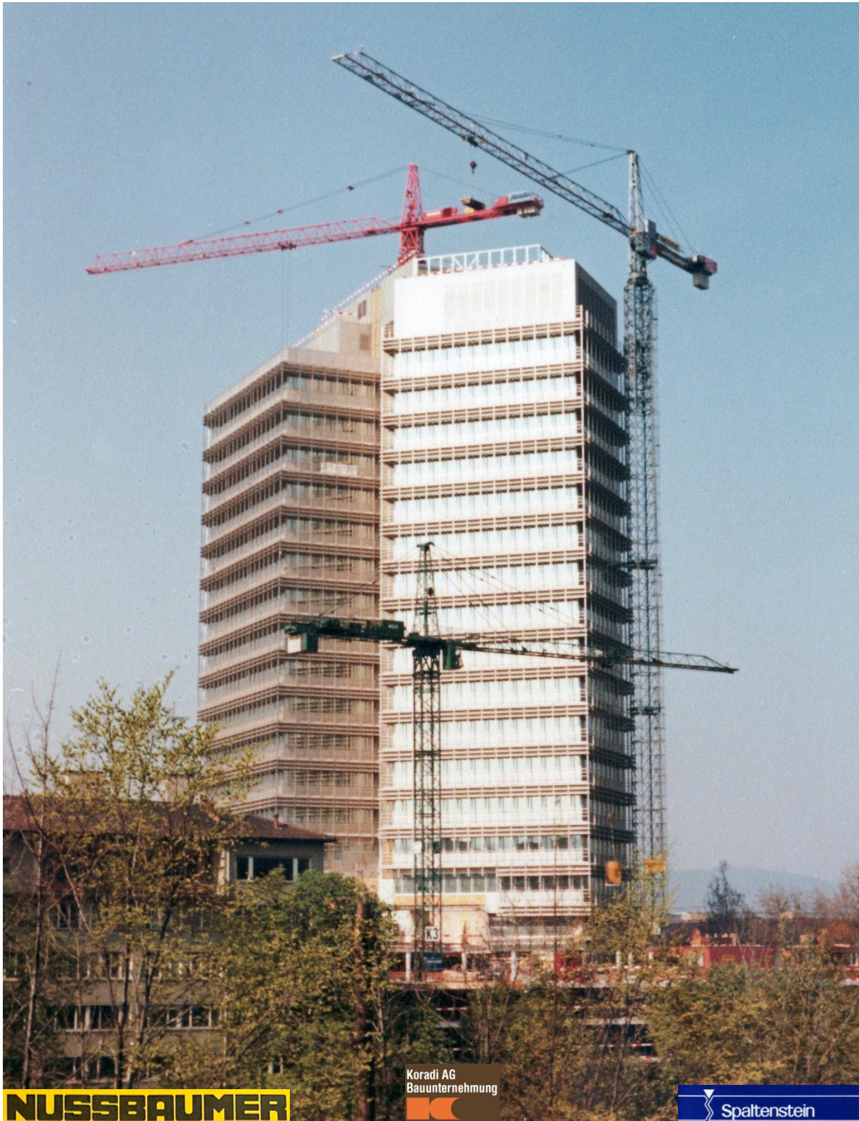
Der +Swiss-Crane+ TKF 1200 wird abgeklettert. Foto Archiv Pius Meyer 1980.
