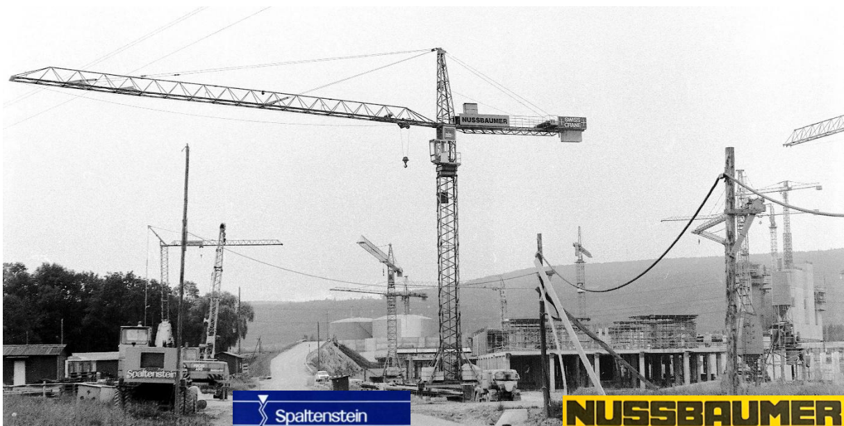
Gleichzeitig mit dem Heizkraftwerk wurde das Gewerbezentrum Wallisellen erstellt. Ausführende Firmen waren Nussbaumer aus Wallisellen und Spaltenstein aus Zürich. Nussbaumer setzte einen +Swiss-Crane+ TKF 402 und einen SIMMA 1041 auf Schienenfahrwerken ein. Spaltenstein einen Richier- Weitz GT 1295 und einen Wolff WK 60 S. Als Lagerplatzkran diente ein +Swiss-Crane+ TKF 150 der Firma Nussbaumer. Heute nicht mehr vorstellbar, dass solch grosse Baustellen mit Kranen der 40 – 60 mt Klasse bedient wurden. Das Foto wurde ebenfalls im August 1976 durch Pius Meyer aufgenommen.
