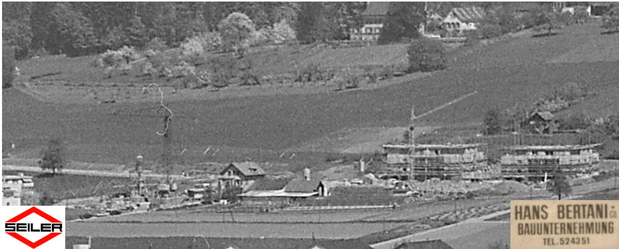
Der Pingon P 50 der Firma W. Seiler wurde noch für viele Baustellen in Oberengstringen eingesetzt, wie hier 1969 im Gebiet Märzenbühl/ Sunneberg. Rechts war ein Liebherr Form 20 A der Firma Hans Bertani gleichzeitig im Einsatz. Foto ETH Bildarchiv.
