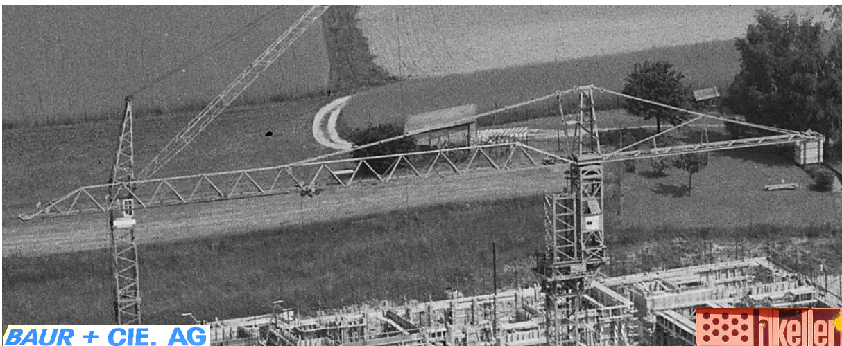
Baustelle des Spital Limmattal 1967. Besonders war damals der am Betten- Hochhaus eingesetzte Peingeon- Somalev, welcher zum Klettern den ganzen Kranoberteil nach hinten verschob, um weitere Turmstücke einsetzen zu können. Foto ETH Bildarchiv.
