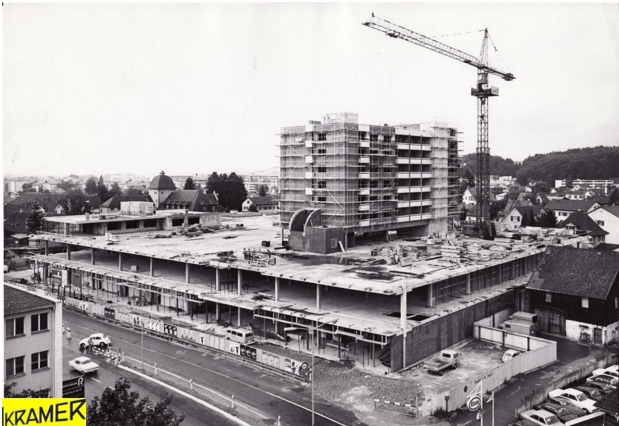
Detail Peiner KL 160 auf der Baustelle Illuster 1972 und KL 80 unten 1973. Foto Pius Meyer.
