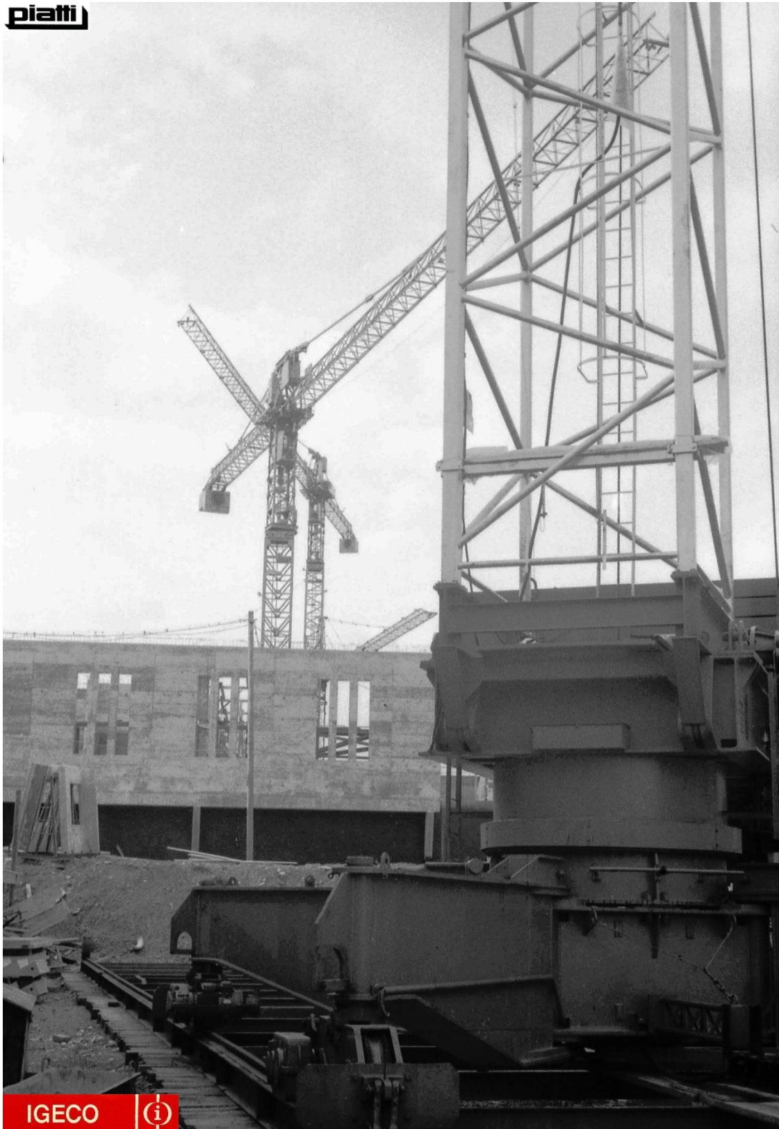
Für die Elementmontage setzte die Firma IGECO einen Peiner T 125 Spezial ein. Im Hintergrund zwei Richier- Weitz GT 1184 der Firma Piatti. Foto Pius Meyer 1972.
