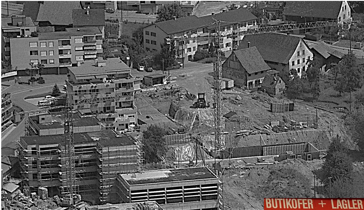
Geroldswil Zentrumsbaustelle 1972. Pingon P 50 und Edilmac E 701. Foto ETH Bildarchiv.
