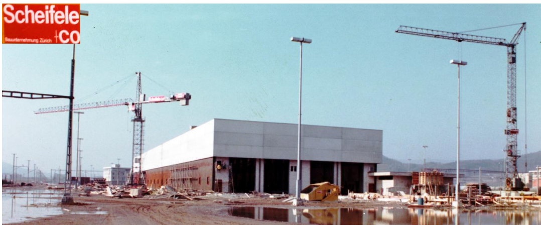
Auch am Bau der Ortsgüteranlagen war die Firma Scheifele + Co aus Zürich. Angeschafft wurde 1973 ein +Swiss-Crane+ TKF 1600 mit 56 m Ausladung aus speziellem fahrbarem Unterwagen mit nur 4.6 m Spurweite. Rechts davon ein +Swiss-Crane+ EBK 750. Foto Archiv Scheifele oben und Willi Burkart unten.
