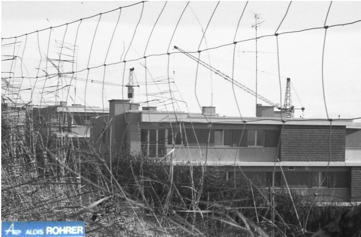
PKZ Form TK 18 und IBAG Form 30, Bauunternehmung Alois Rohrer Ing. aus Zürich, 1970 an der Eggstrasse in Oberengstringen. Foto Pius Meyer.
