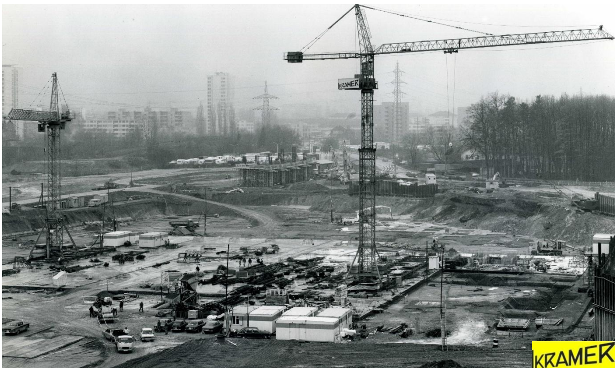
Die Glatt Baustelle Ende 1972. Peiner KL 100 links, KL 80 rechts. Foto Victor Rödelberger.
