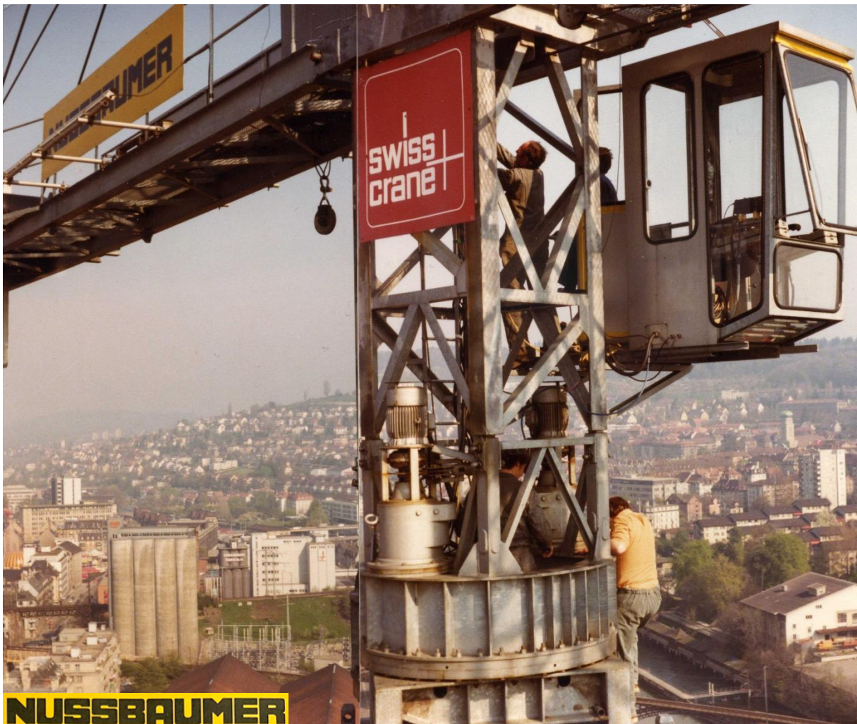
+Swiss-Crane+ TKF 1200 während des Abkletterns auf der Baustelle Migros Limmatplatz 1980. Um die Turmstückhälften entfernen zu können, musste am Gegenausleger eine Umlenkrolle angebracht werden. Foto Urs Frischknecht.
