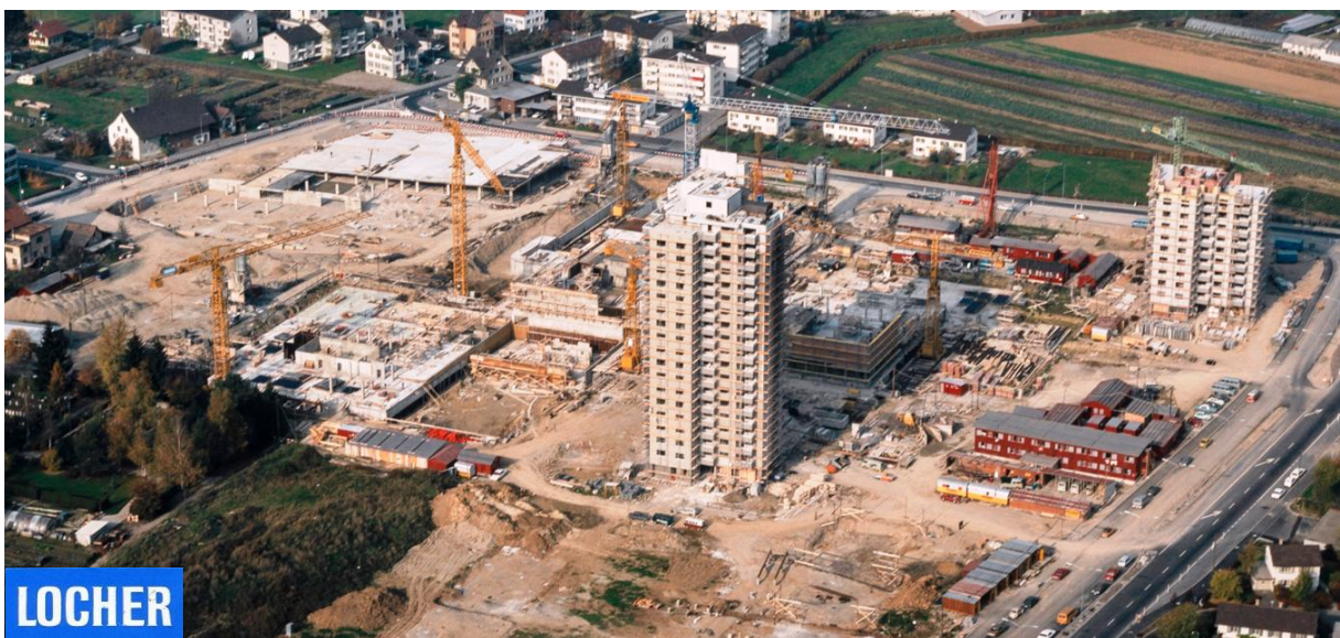
Baustelle des Zentrums Regensdorf 1971. Foto ETH Bildarchiv.
