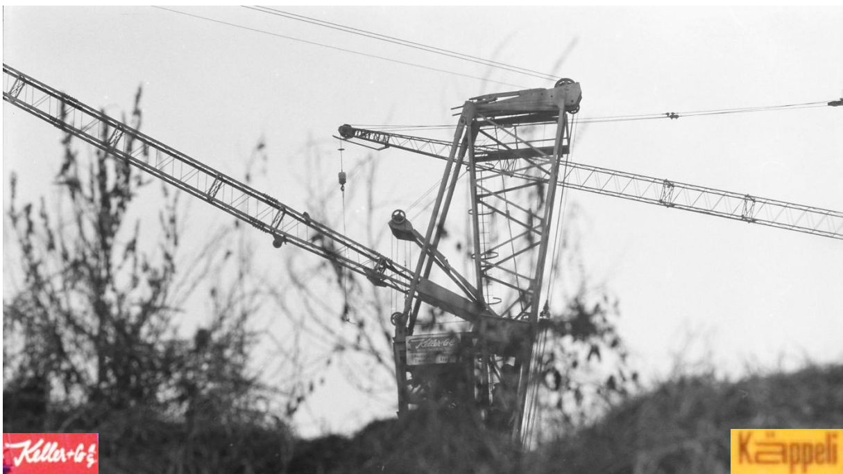
Zürich Seebach, Gebiet Köschenrütli, 1972. Neben einer neuen Schulanlage wachsen auch Neubauten aus dem Boden. Eingesetzte Krane: Schwing KTK 42 W der Firma Keller & Co., Wolff WK 80 S und EWK Gigant hoch der Th. Bertschinger AG, Wolff Form 45 H der Firma Keller & Co. und Liebherr 45A/65I der Firma Gebr. Käppeli & Co Zürich. Foto vom 05.03.1972 Pius Meyer.
