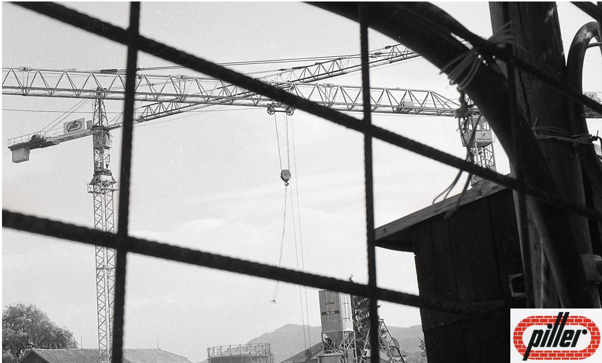
2 x Liebherr 90.2 HC an der Zentrumsbaustelle 1977, Firma J. Piller. Foto Pius Meyer.
