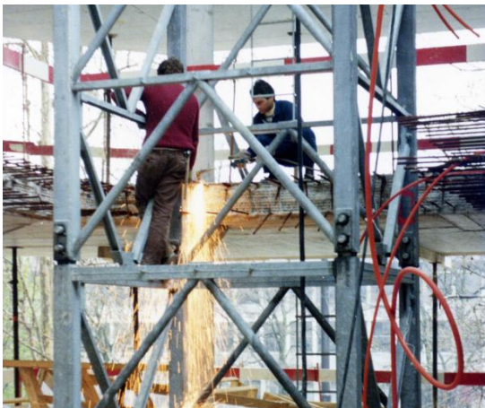
+Swiss-Crane+ TKF 1200 während des Abkletterns auf der Baustelle Migros Limmatplatz 1980. Um die Turmstückhälften entfernen zu können, musste am Gegenausleger eine Umlenkrolle angebracht werden. Foto Urs Frischknecht.
