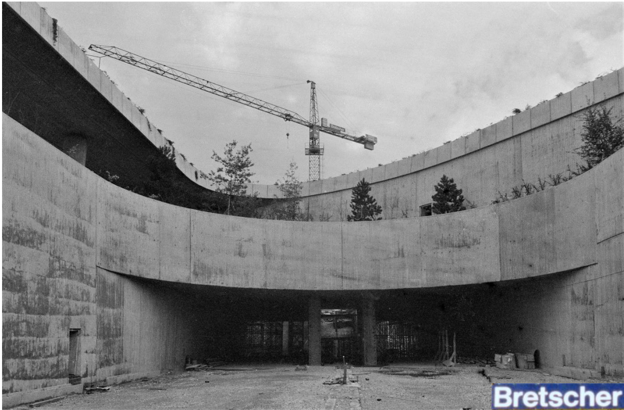
+Swiss-Crane+ TKF 601 Baujahr 1969 mit Innenkabine. 1978 auf der Milchbuckbaustelle.
