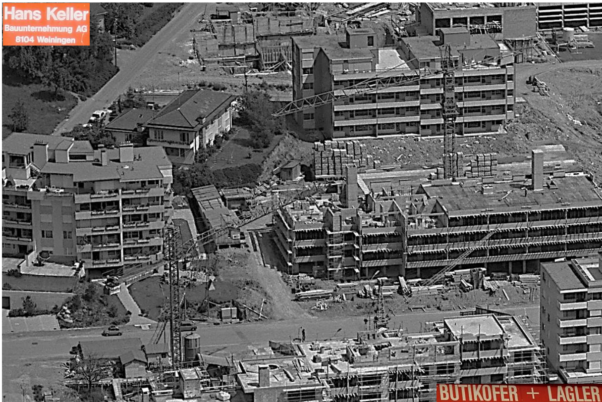
Geroldswil Zentrumsbaustelle 1972. Kroll K 45, IBAG F 30 und Peingeon- Somalev NC 63 A. Foto ETH Bildarchiv.
