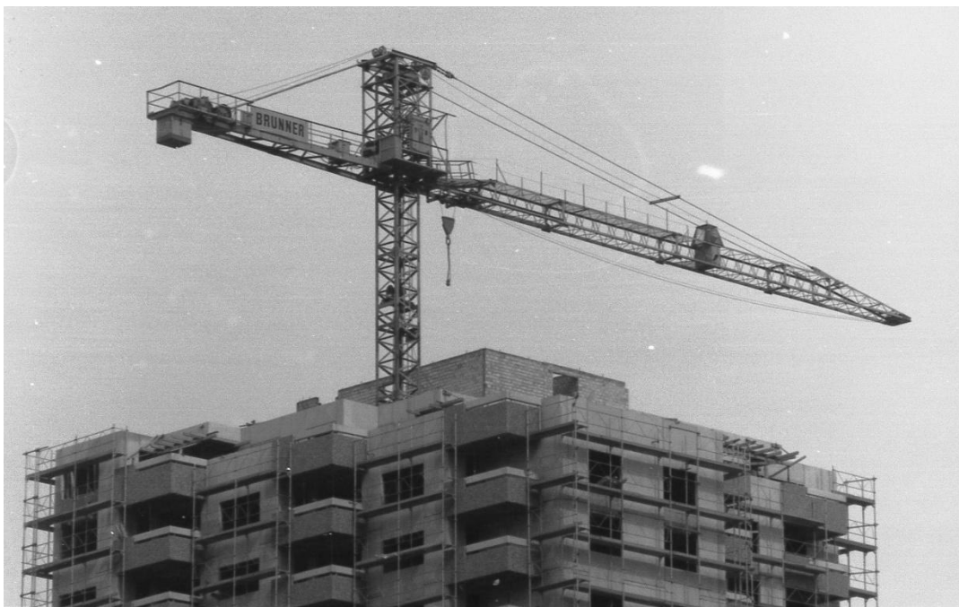
Schwing KTK 35 der Winterthurer Baufirma Brunner. Foto April 1972 Pius Meyer.
