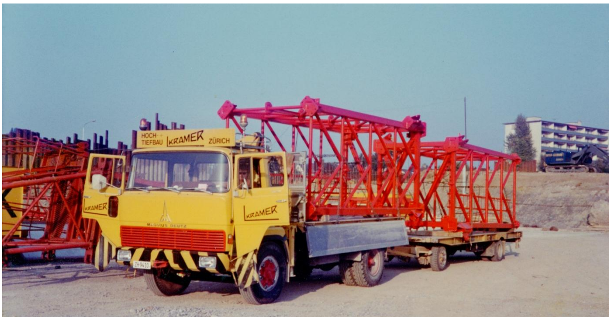
1972 starteten auch die Bauarbeiten für das Grosseinkaufszentrum Glatt in Wallisellen. Die Firma Kramer führte die Baumeisterarbeiten aus. Eingesetzt wurde ein werkneuer Peiner KL 100 in Kramer rot lackiert, einen Peiner KL 80, beide auf Schienenfahrwerken montiert. Das Foto zeigt den Antransport der beiden Unterwagen auf die Baustelle. Foto Archiv Pius Meyer 1972.
