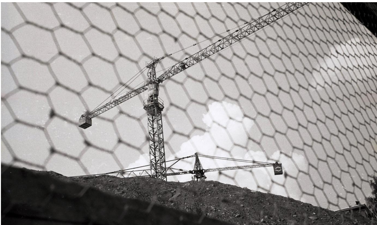
Pingon- Tichauer P 50 der Firma W. Seiler aus Oberengstringen. Dieses Mal eingesetzt in Zürich- Höngg an der Segantinistrasse. Foto vom 6. Mai 1972. Die Einfachheit und leichte Bauweise der Pingon Krane hatte mich damals angesprochen und faszinierte mich. Foto Pius Meyer,
