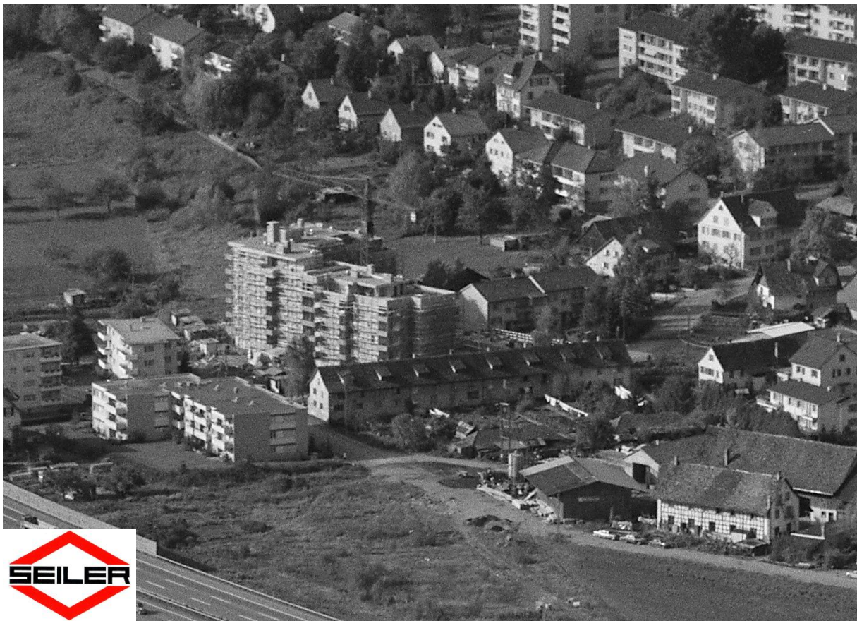
Auch 1973 für diese grosse Wohnüberbauung an der Dorfstrasse, kam der Pingon P 50 der Firma W. Seiler zum Einsatz. Aufgestellt auf einer Stahlkonstruktion über der Tiefgarage, auf welcher sich der Kran auch verfahren konnte. Foto ETH Bildarchiv.
