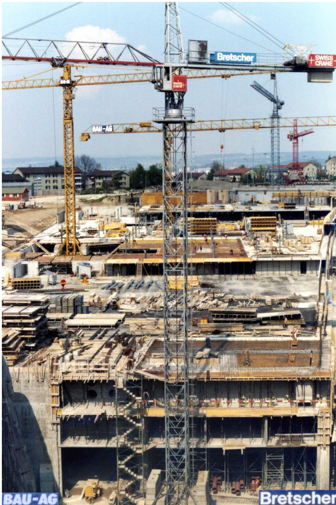
Stand der Bauarbeiten 1981. Oberhalb des Tunnels erstellte die Firma Bau AG Zürich ein Parkhaus für die Universität Irchel. Ein Weitz GT 1184 und GT 1295 S1 wurde dazu montiert.
