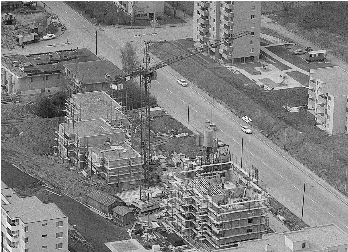
Wolff WK 80 S der Firma Schwager 1972, eingesetzt für eine Überbauung im Aegelsee in Unterengstringen. Foto ETH Bildarchiv oben und Pius Meyer unten.
