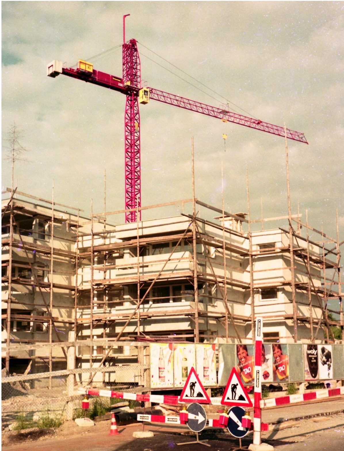
Ein neuer Kroll K 100 wird ab 1973 in Zürich Höngg im Riedhofgebiet für ein Hochhaus eingesetzt. In der zweiten Bauphase wurde der Kran verankert und geklettert. Bauunternehmung Bosshardt Bau AG aus Zürich. Foto Intermac Archiv Pius Meyer.
