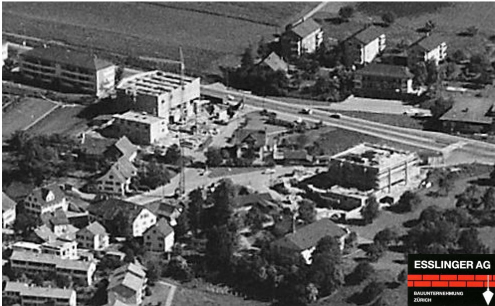
1963 an der Zürcherstrasse in Oberengstringen. Die Katholische Kirche befand sich in Bau. Die Firma A. Esslinger setzte dafür einen Wolff Form WK 33 H ein. Unterhalb vom gerade fertiggestellten Gemeindehaus kam wiederum ein EWK Rex zum Einsatz. Foto ETH Bildarchiv.
