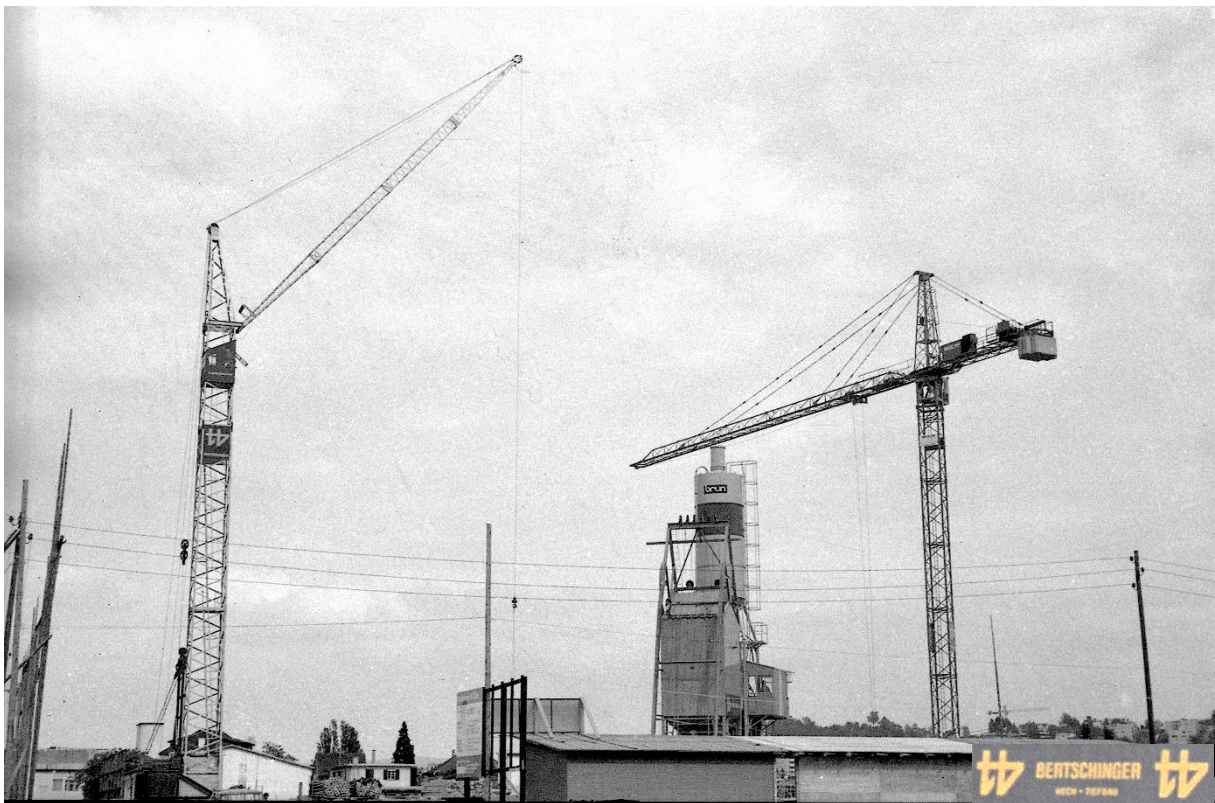
Ebenfalls in Schlieren in der Industriezone 1972, ein EWK SBK 36 «Gigant» hoch und ein Wolff WK 80 S der Baufirma Th. Bertschinger aus Lenzburg. Foto Pius Meyer.
