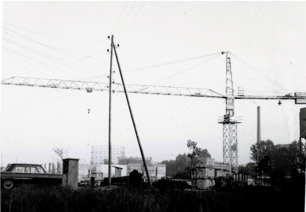
+Swiss-Crane+ TKF 601, Baujahr 1969, Firma W. Seiler, beim Ersteinsatz an der Allmendstrasse 3 in Oberengstringen. Foto Bachmann AG Beringen.
