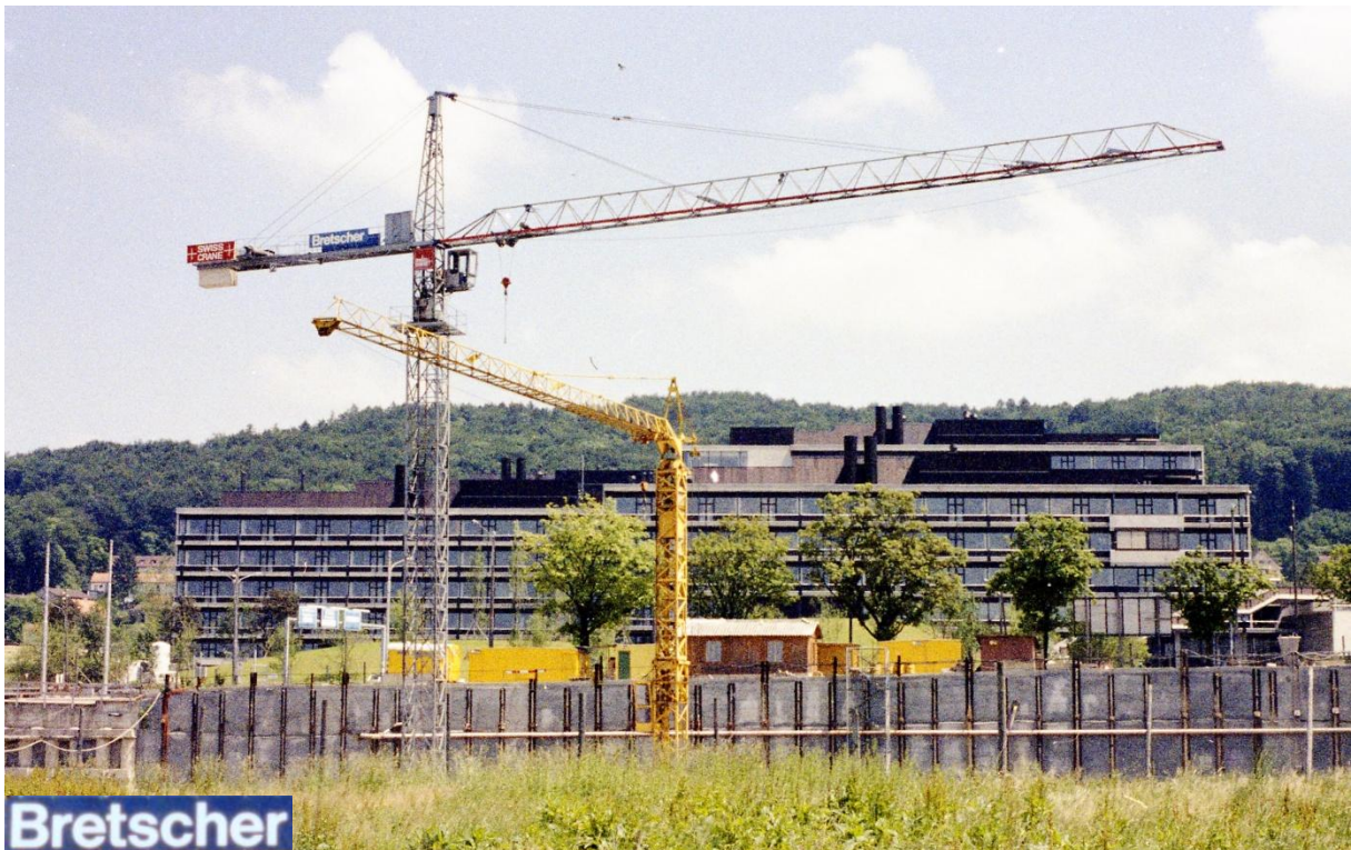
+Swiss-Crane+ TKF 801 und Cadillon C 10-20 der Firma Bretscher. Foto Pius Meyer.
