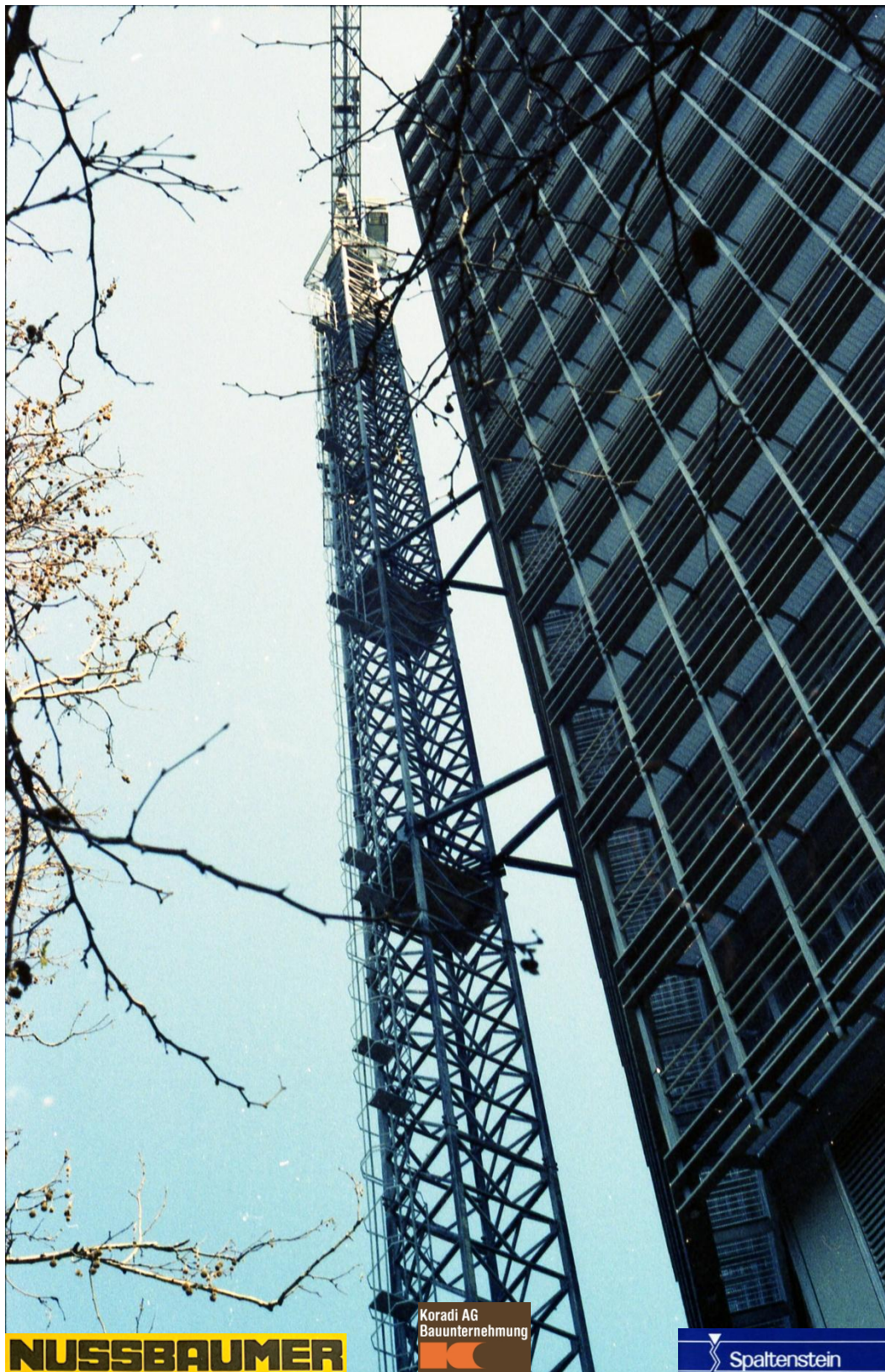
Doppelte Gebäudeabspannung am +Swiss-Crane+ TKF 1200. Foto Pius Meyer 1980.
