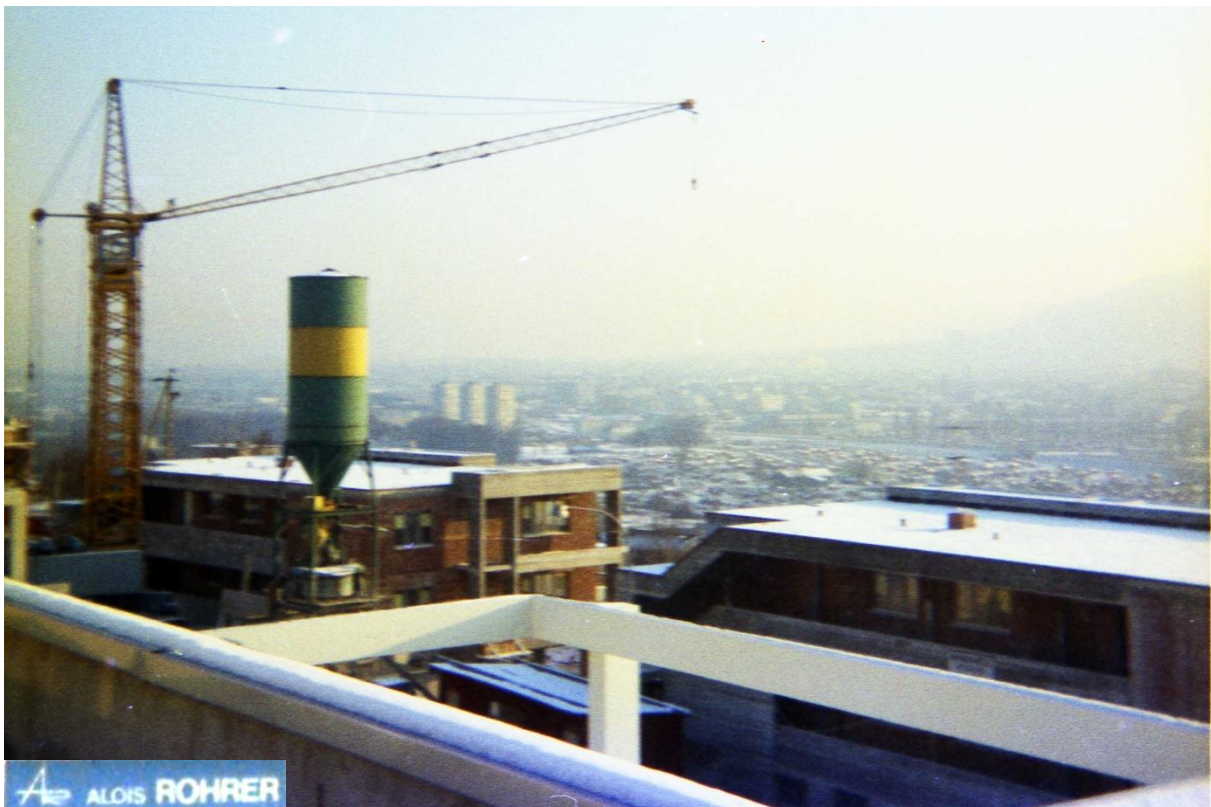
PKZ Form TK 18 und IBAG Form 30, Bauunternehmung Alois Rohrer Ing. aus Zürich, 1970 an der Eggstrasse in Oberengstringen. Foto Pius Meyer.
