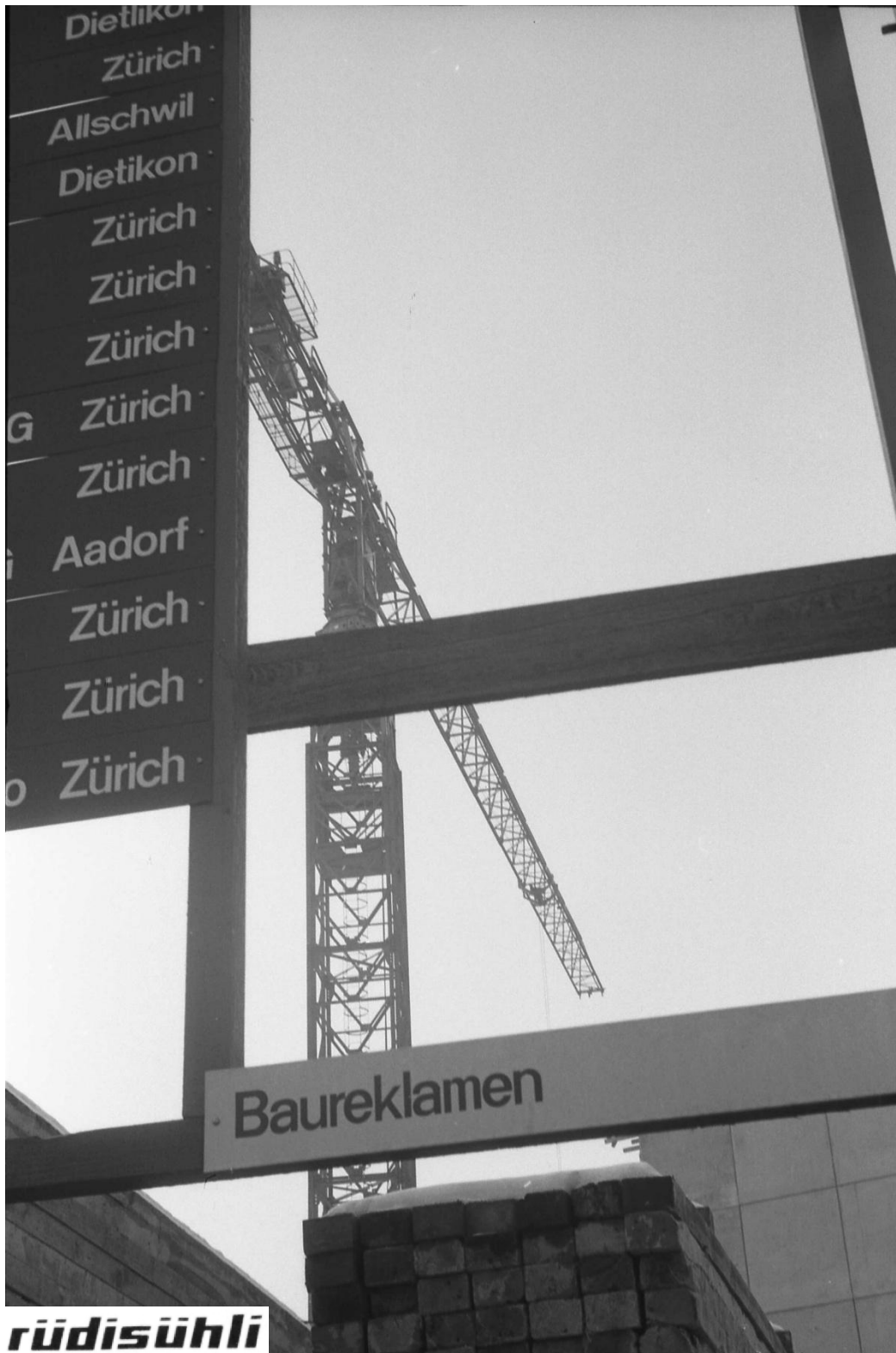
Richier- Weitz GT 1295 R5 der Firma Rüdüsühli 1971 an der K 3000 Baustelle in Oberengstringen. Foto Pius Meyer.
