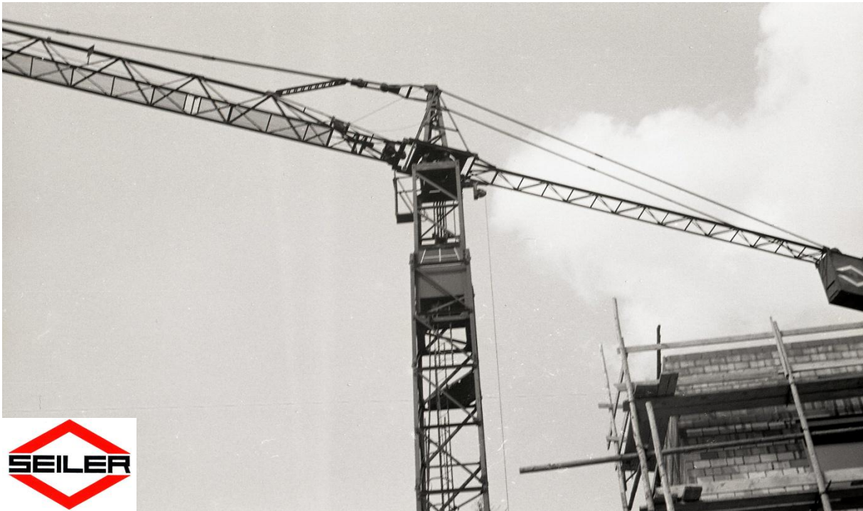
Pingon- Tichauer P 50 der Firma W. Seiler aus Oberengstringen. Dieses Mal eingesetzt in Zürich- Höngg an der Segantinistrasse. Foto vom 6. Mai 1972. Die Einfachheit und leichte Bauweise der Pingon Krane hatte mich damals angesprochen und faszinierte mich. Foto Pius Meyer,
