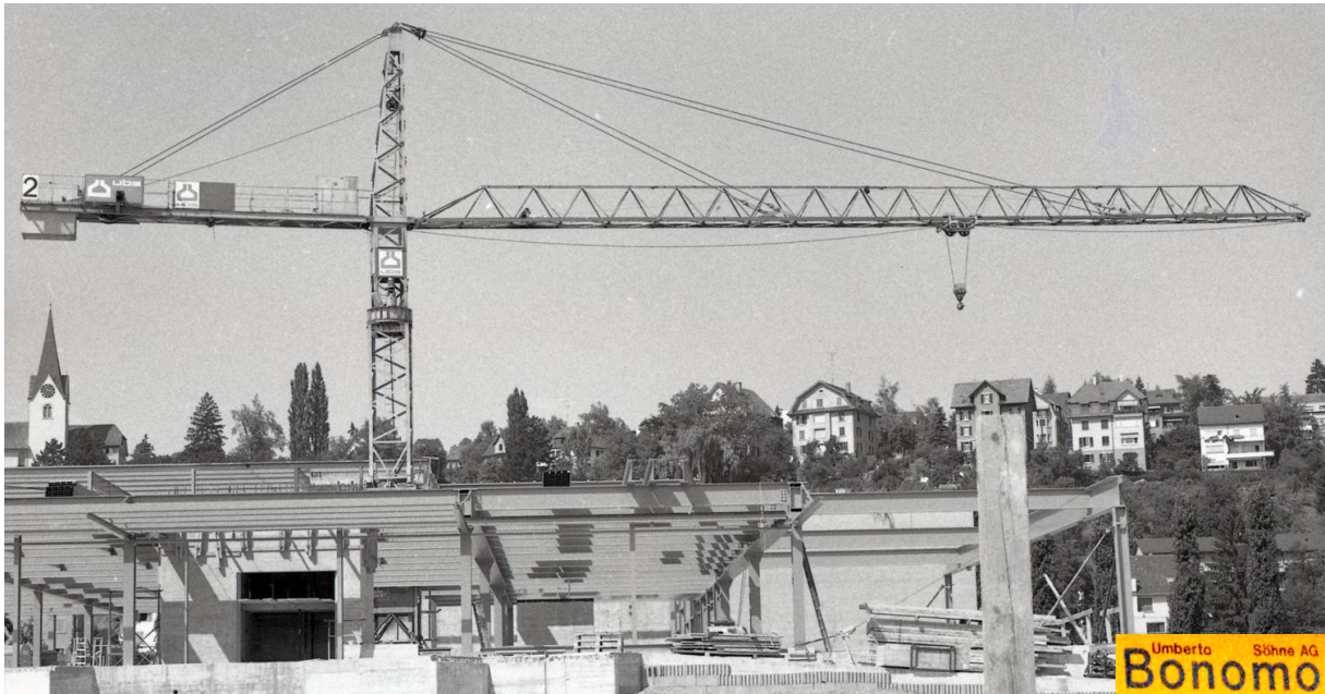
1976/ 77 kommt der +Swiss-Crane+ TKF 1200 der Firma Umberto Bonomo's Söhne aus Zürich für die Erweiterung des Wasserwerks Zürich zum Einsatz. Mit Baujahr 1967 war der Kran damals bereits 10 Jahre alt. Foto oben und unten Pius Meyer.
