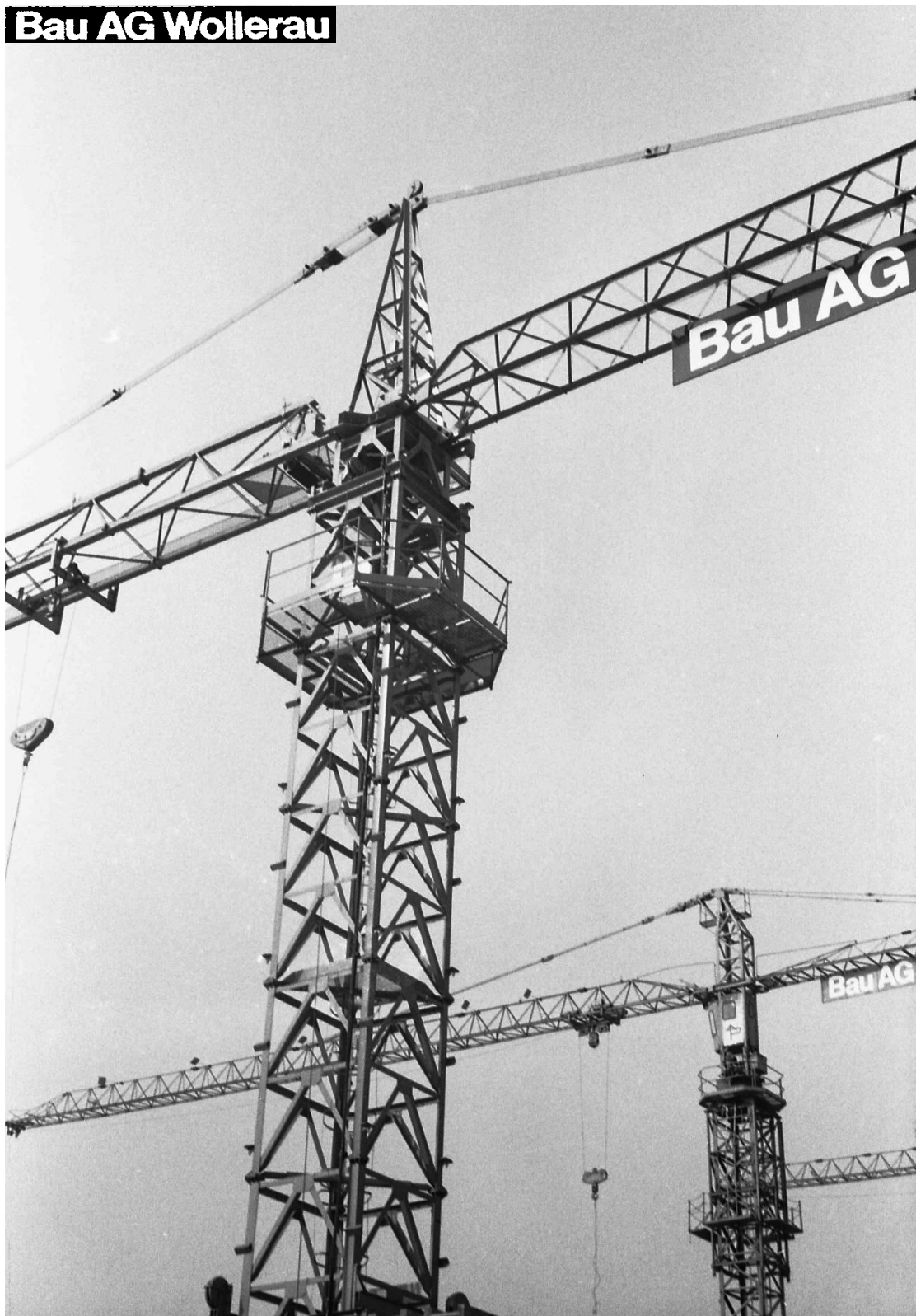
Auf der gleichen Niedermann Baustelle in Schlieren eingesetzt, ein Raimondi TK 4010, ebenfalls 1972 aufgenommen durch Pius Meyer.
