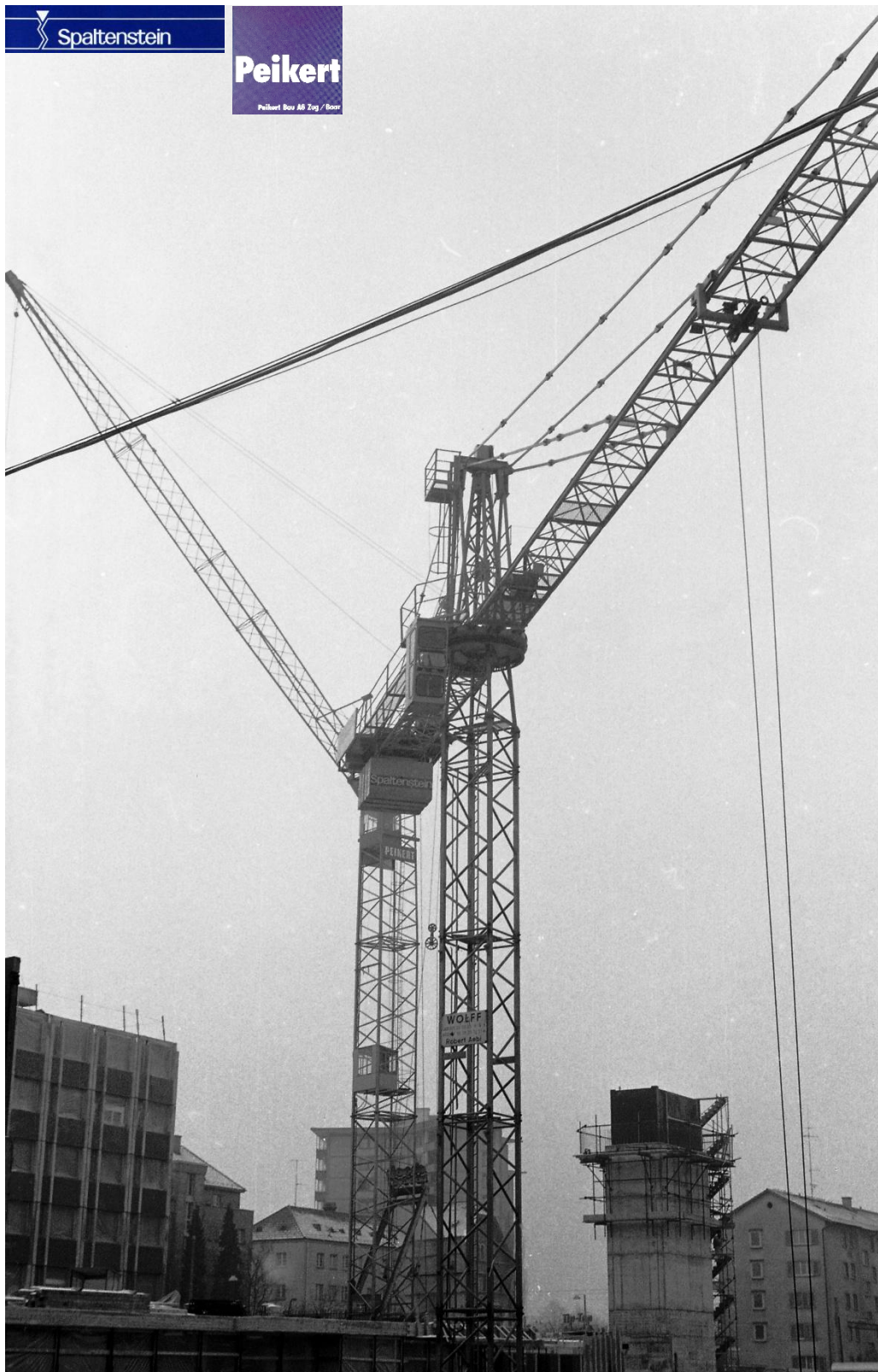
Wolff Form 60 S mit Rollendrehkranz und Peiner T 125 auf der Nova Park Baustelle 1972. Foto Pius Meyer.
