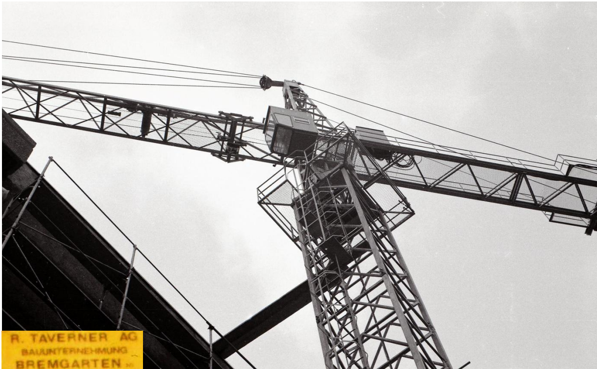
1971 begannen die Bauarbeiten für einen Wohnblock an der Sonnenhofstrasse in Schlieren, mit einem damals neuen +Swiss-Crane+ TKF 601, der Baufirma Taverner aus Bremgarten. Foto Pius Meyer.
